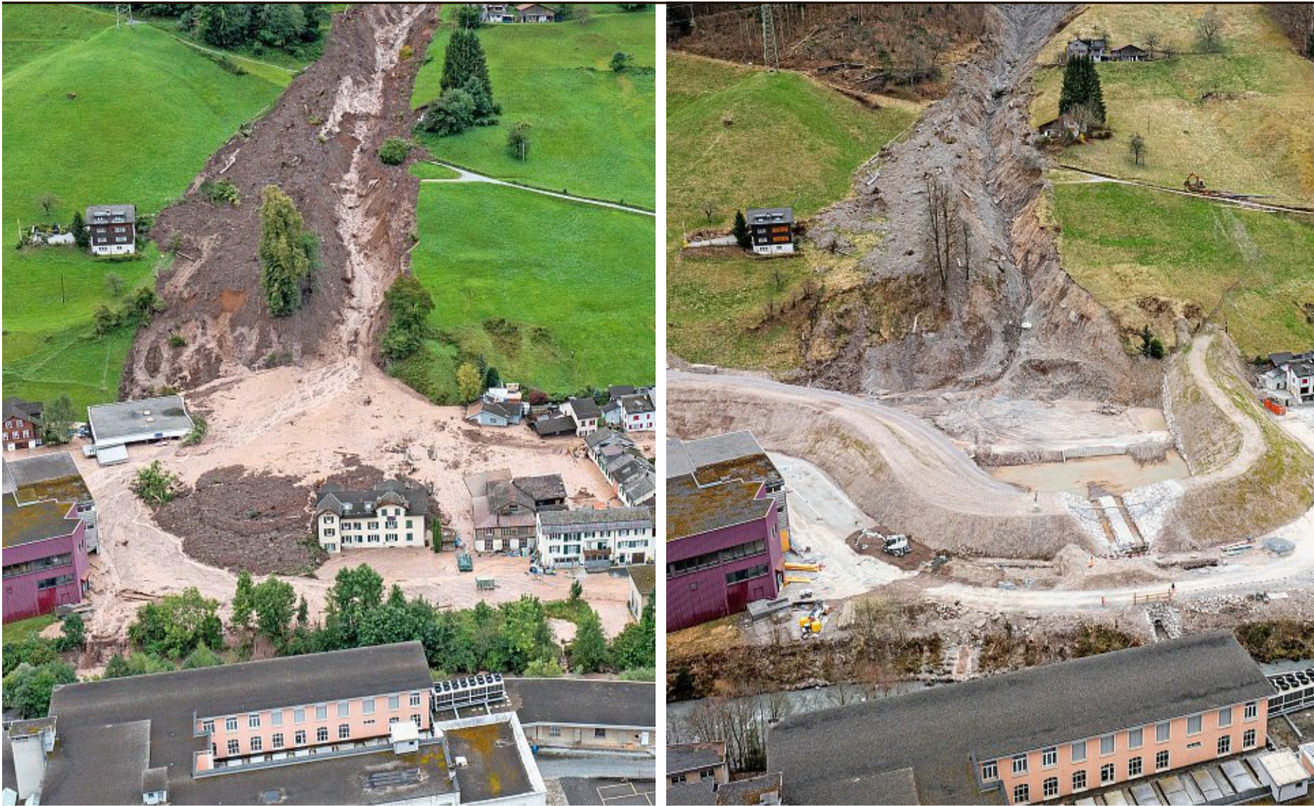
Am 29. August 2023 verwüstete ein Erdbeben Teile des Dorfes: Wo einst Gebäude standen, schützt heute ein Damm (rechts) die Bevölkerung. Fotos: Ela Çelik («20 Minuten»)/Manuela Matt
